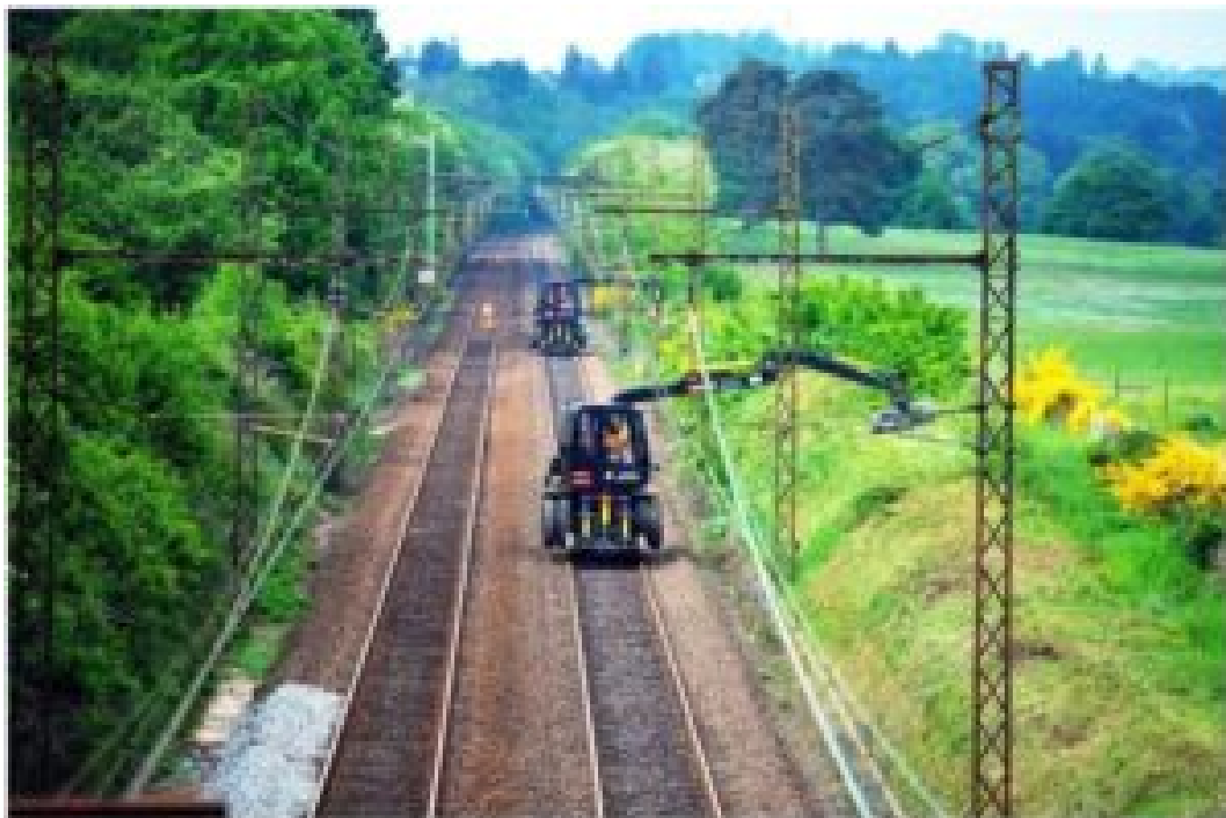
SNCF Travaux sur l'axe POLT chantier de débroussaillage © stephane Lefèvre
